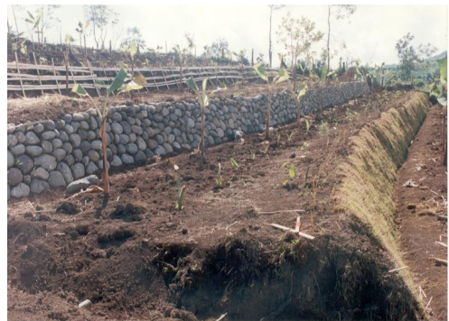
Gambar 6.7. Teras bangku pada lahan miring (kiri) dan jenis penguat tampungan teras (kanan)
